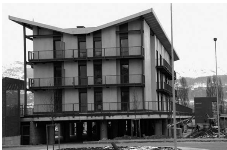
Edificio del Piano CASE (Area Paganica 2).
